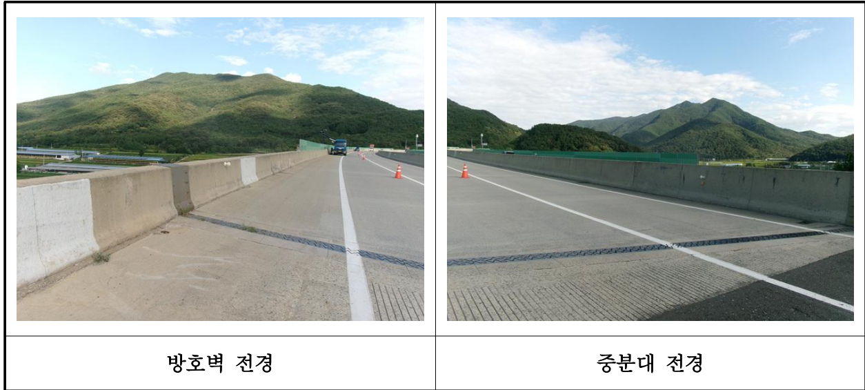
【사진 8.3.24】 방호벽 및 중앙분리대 전경
