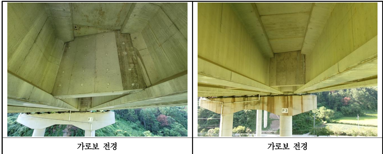
【사진 8.3.6】 가로보 전경
