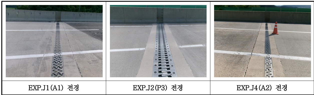
【사진 8.3.17】 신축이음장치 전경
