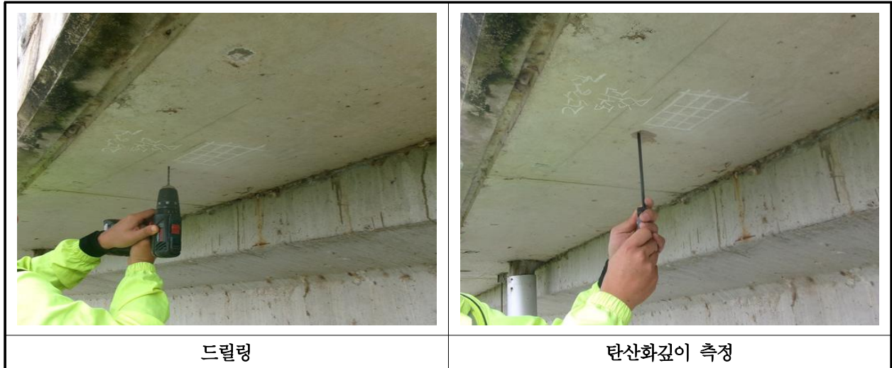
【사진 8.4.3】 탄산화 깊이 측정 현장사진
