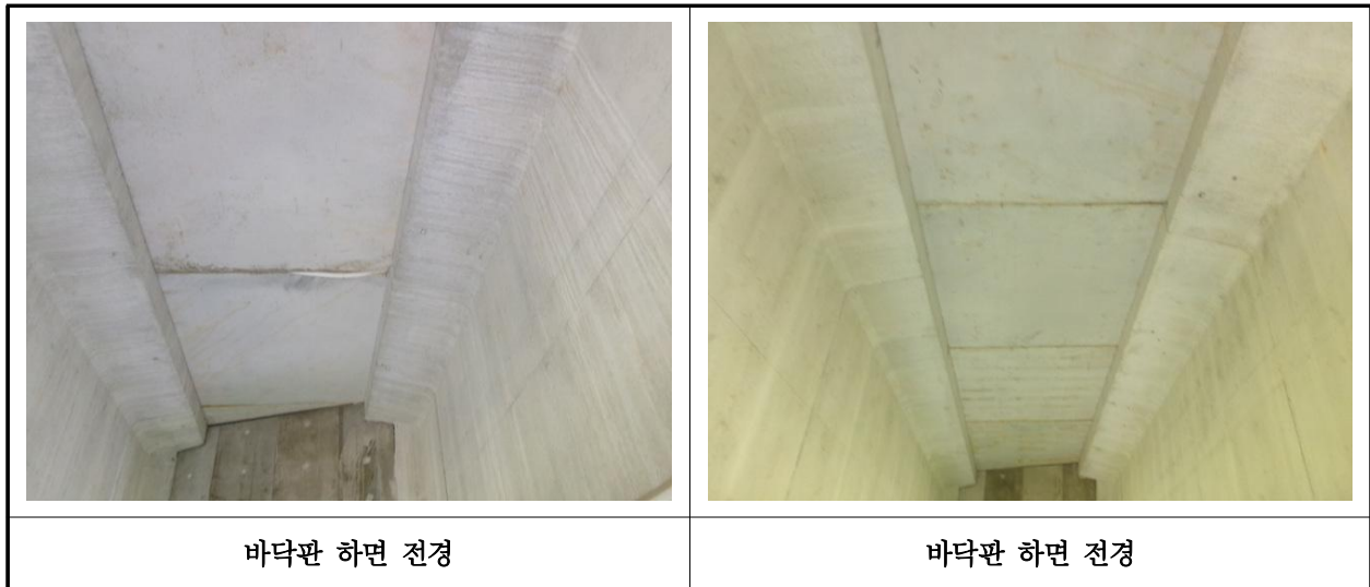
【사진 8.3.2】 바닥판하면 전경
