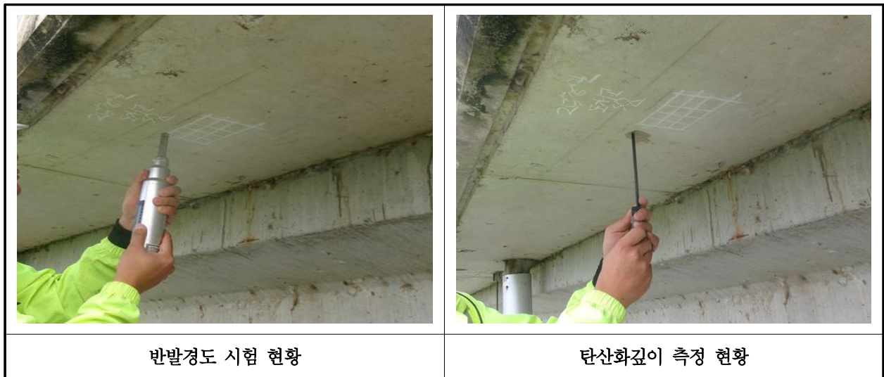
【사진 8.4.1】 콘크리트 내구성조사 현황
