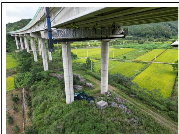
부재 현장측정 전경
