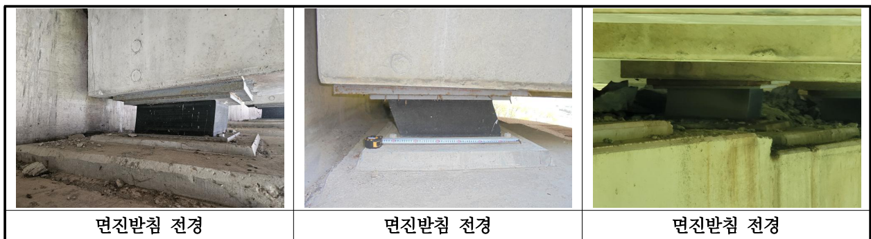
【사진 8.3.13】 교량받침 전경
