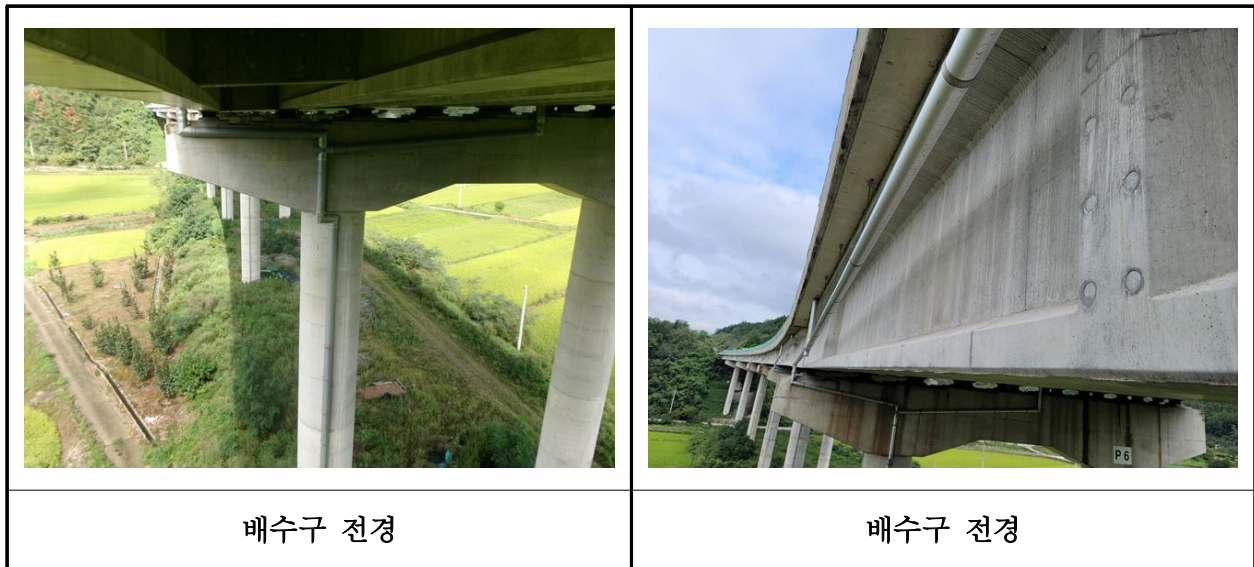
【사진 8.3.22】 배수시설 전경
